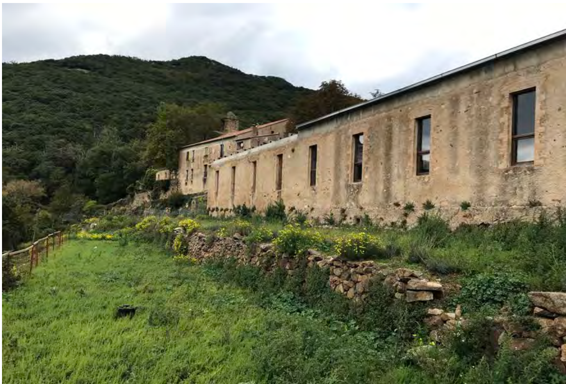
Façana sud de l'edifici existent
